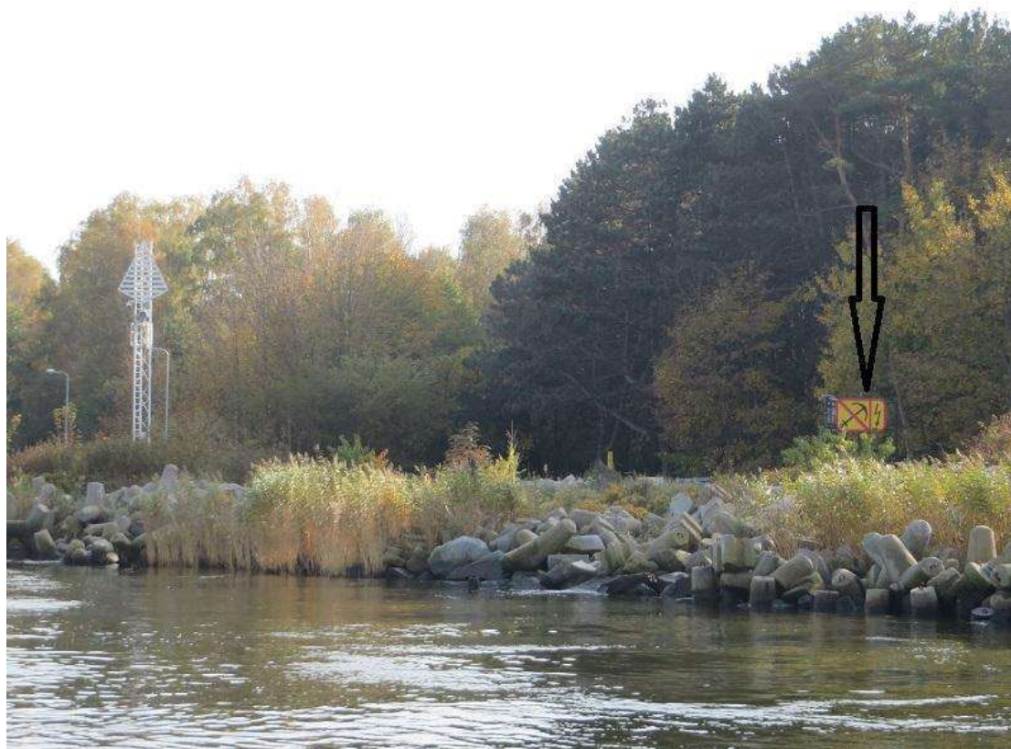
Ryc. 25. Kabel światłowodu KSBM – lokalizacja.
