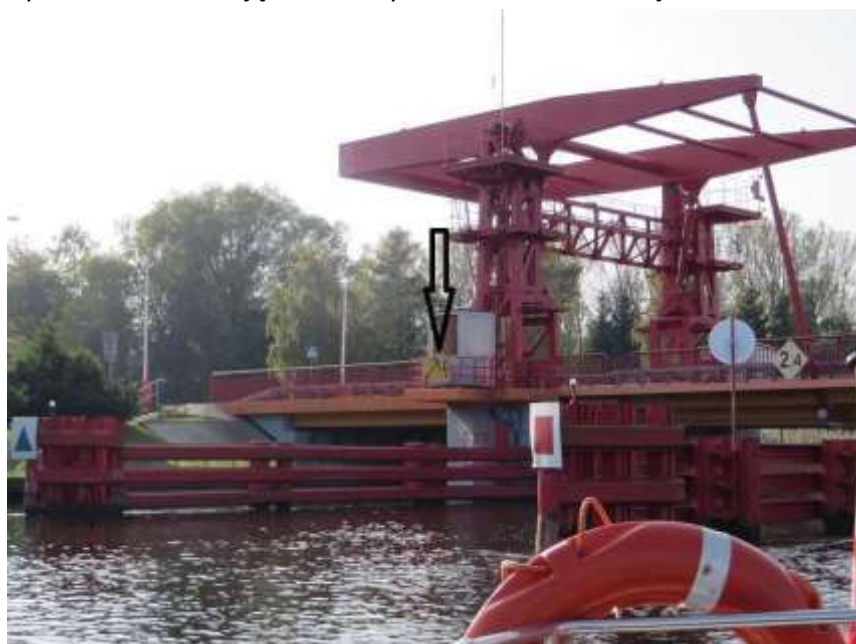
Ryc. 27. Kabel zasilające szlabany na moście – lokalizacja.
