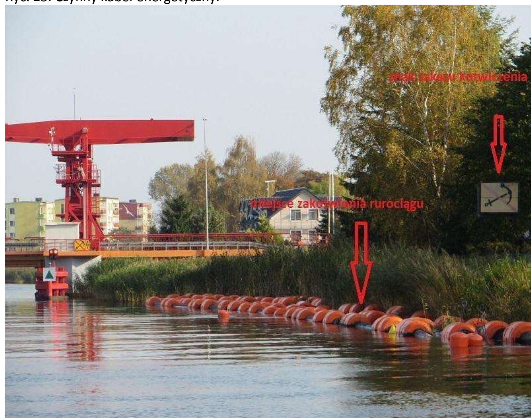
Ryc. 23. Czynny kabel energetyczny.
