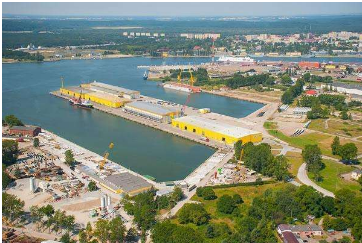
Ryc. 24. Widok z lotu ptaka na Euro Terminal
