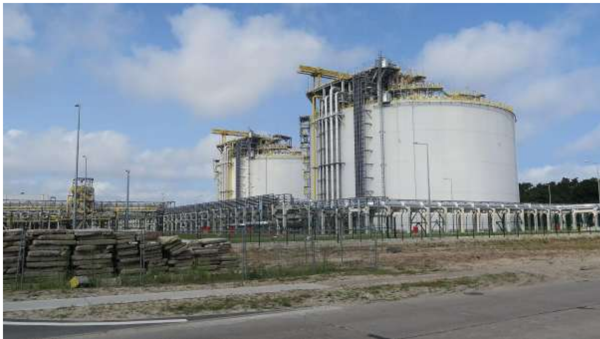
Ryc. 20. Zbiorniki gazu – terminal LNG
