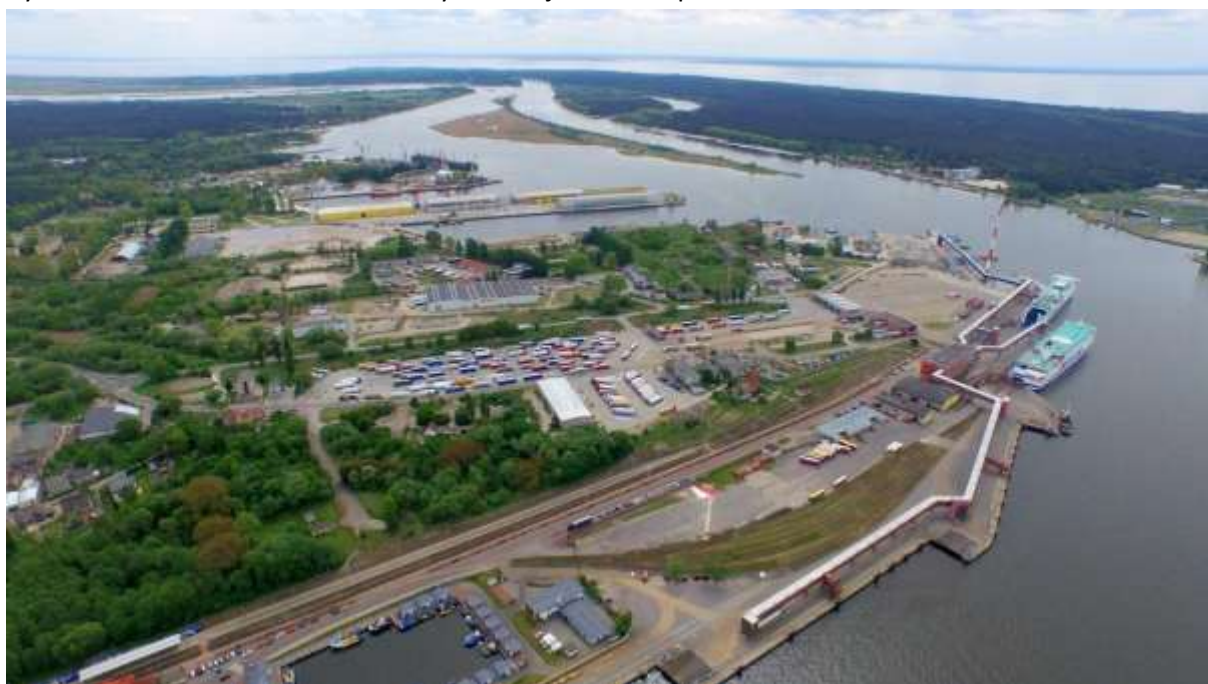
Ryc. 18. Widok na Terminal Promowy Świnoujście z lotu ptaka
