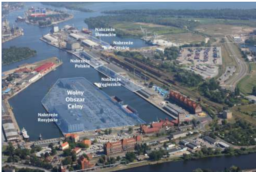
Ryc. 11. Nabrzeża terminalu drobnicowego.
