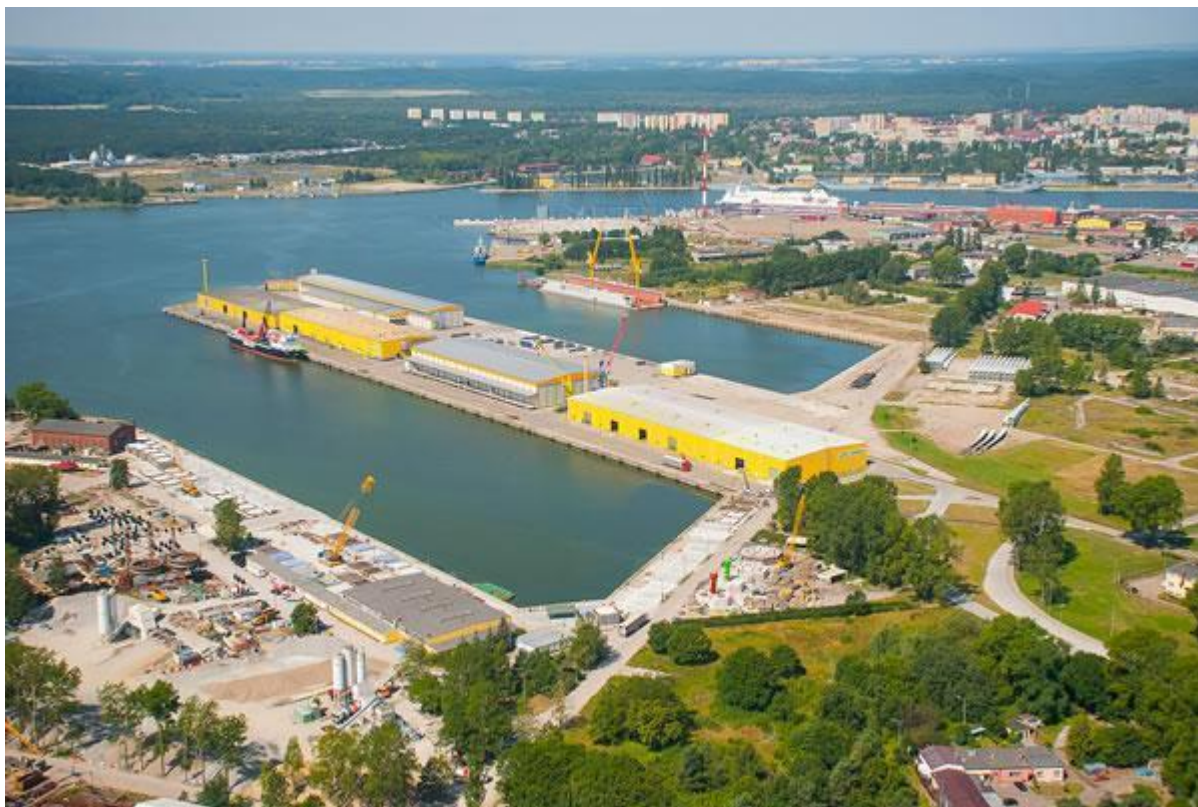
Ryc. 21. Widok z lotu ptaka na Euro Terminal
