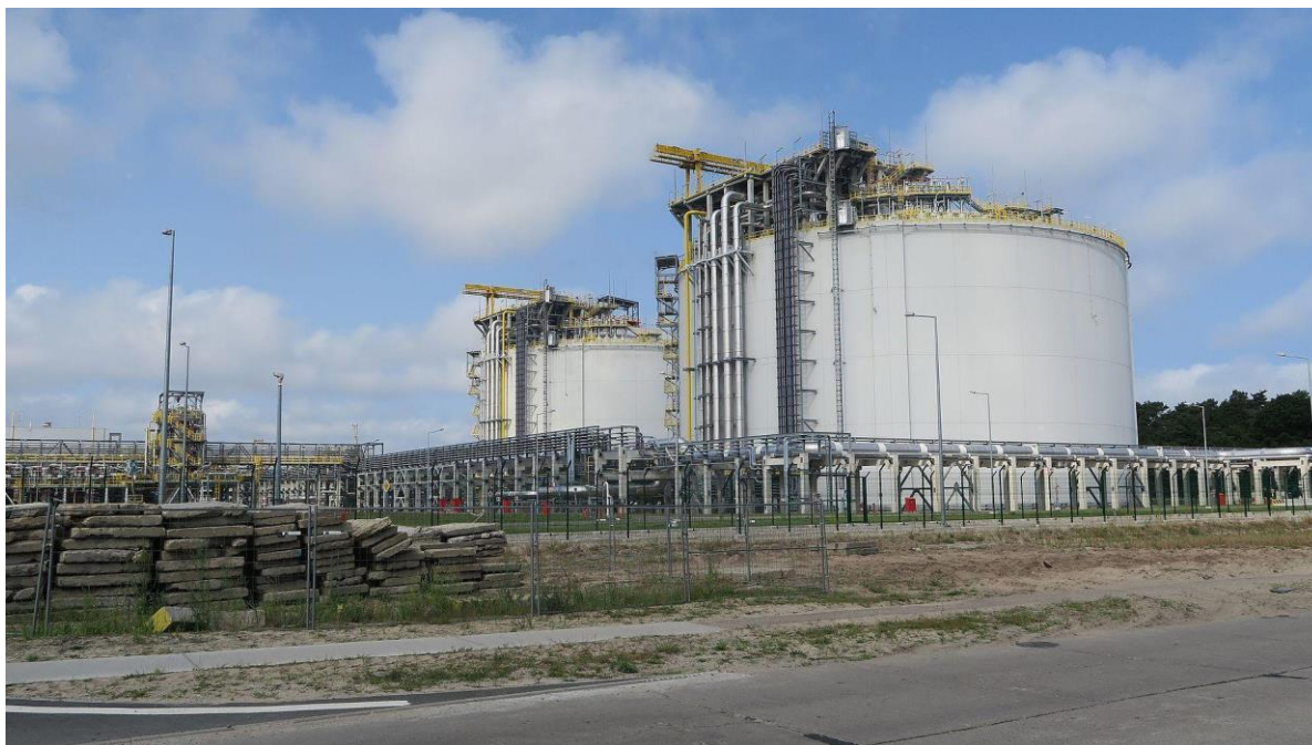
Ryc. 16. Zbiorniki gazu – terminal LNG
