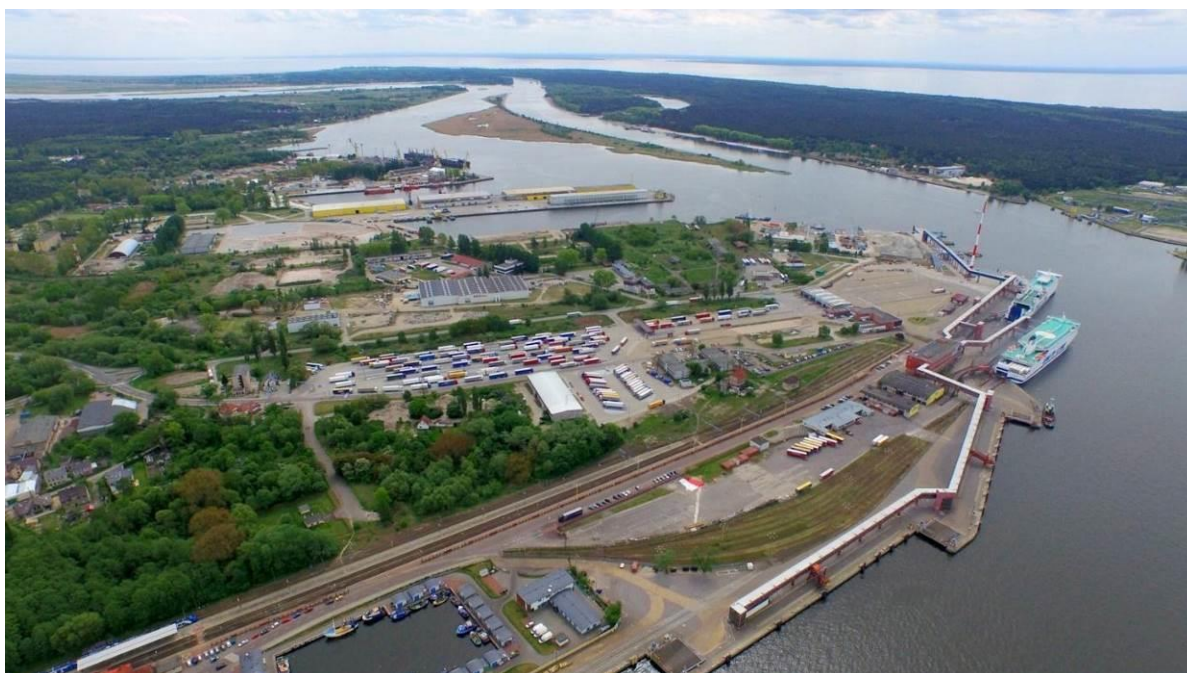
Ryc. 14. Widok na Terminal Promowy Świnoujście z lotu ptaka
