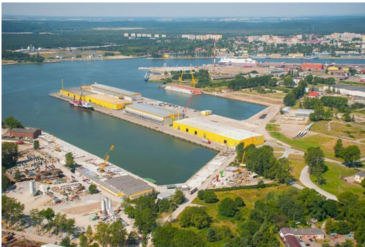
Ryc. 21. Widok z lotu ptaka na Euro Terminal
