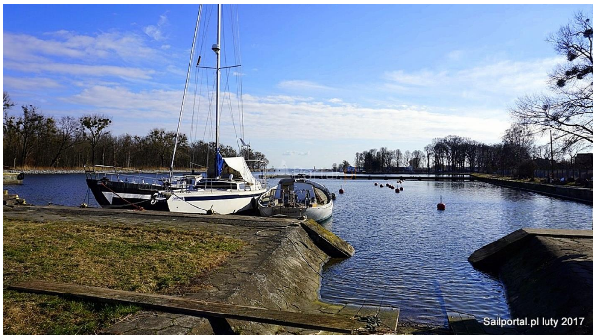
Ryc. 24. Marina w Trzebieży przed remontem, luty 2017
