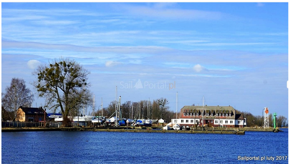
Ryc. 25. Marina w Trzebieży przed remontem, luty 2017
