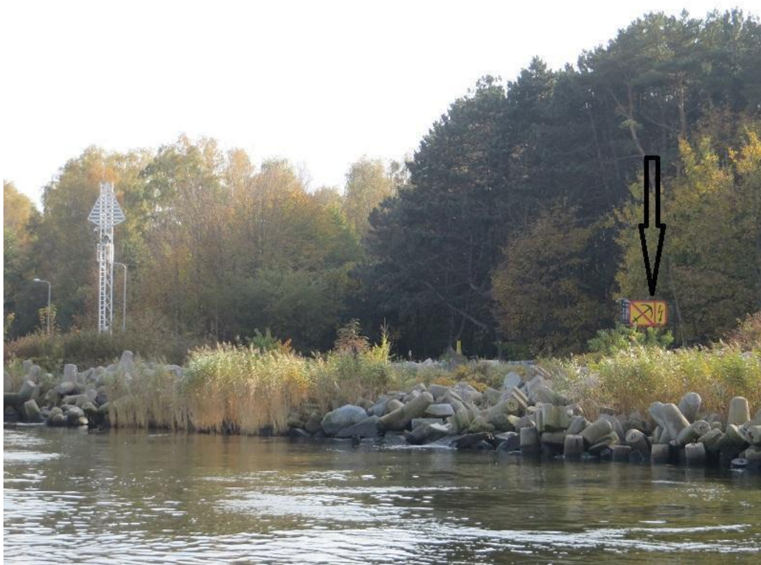
Ryc. 28. Kabel światłowodu KSBM pod dnem Dziwny – lokalizacja.
