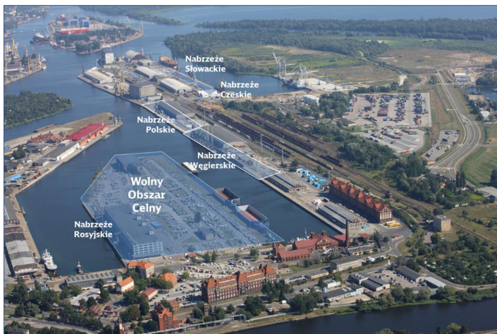
Ryc. 8. Nabrzeża terminalu drobnicowego.
