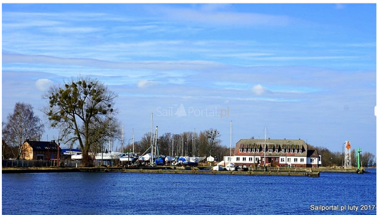
Ryc. 25. Marina w Trzebieży przed remontem, luty 2017
