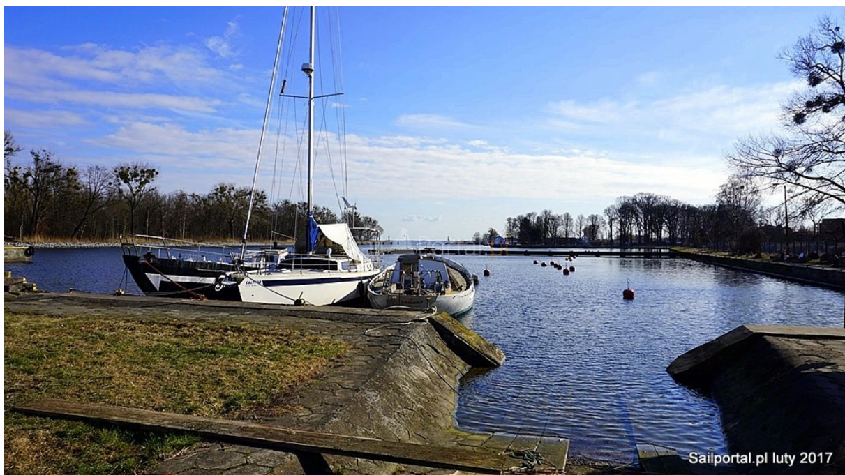
Ryc. 24. Marina w Trzebieży przed remontem, luty 2017
