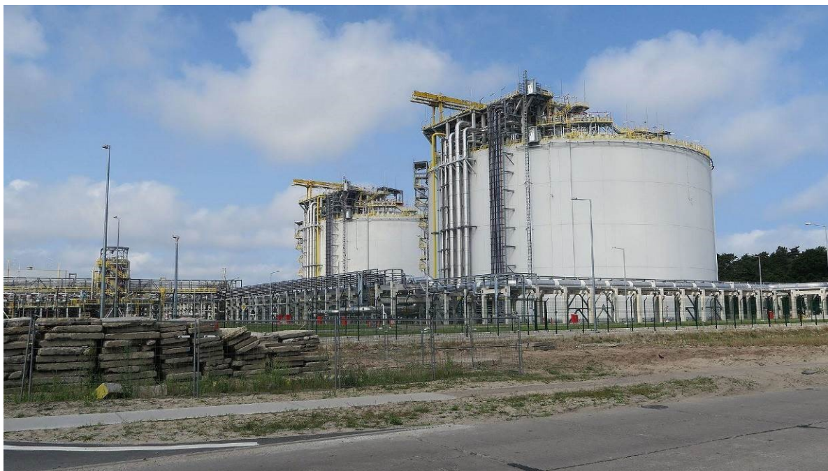
Ryc. 16. Zbiorniki gazu – terminal LNG
