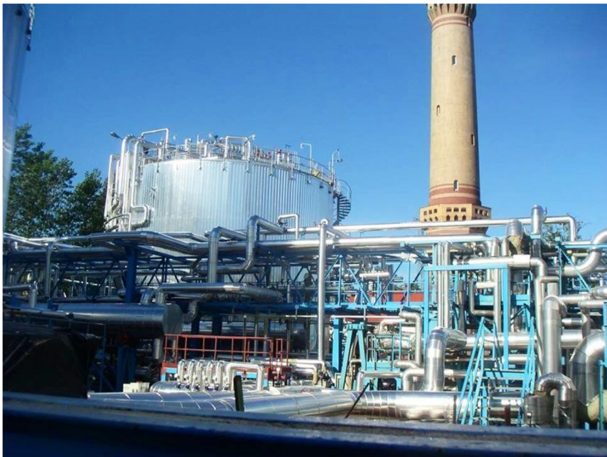
Ryc. 10. Nabrzeże Chemików – Terminal Deza
