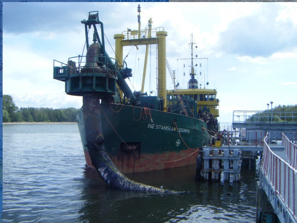
Prace czerpalne na torze wodnym Świnoujście - Szczecin
