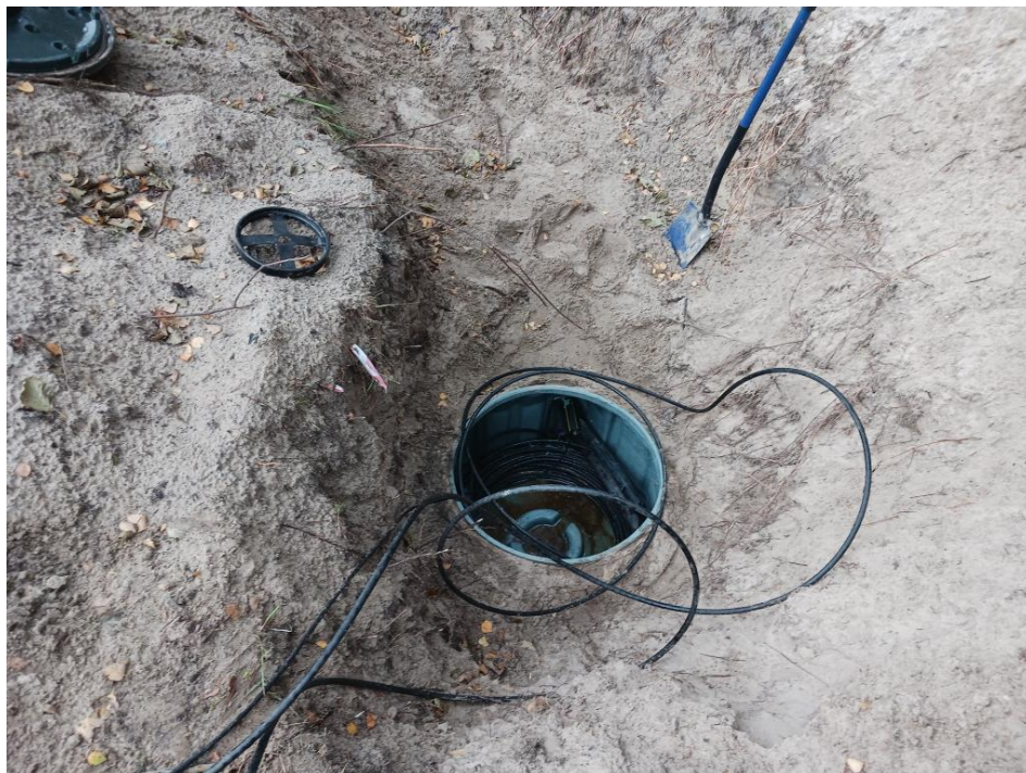
Fot. 1 Budowa przyłącza światłowodowego w Pobierowie (zasobnik kablowy)
