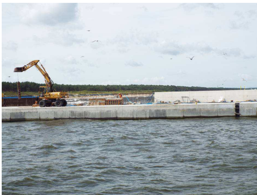
Zdjęcie 4 roboty żelbetowe na falochronie zachodnim
