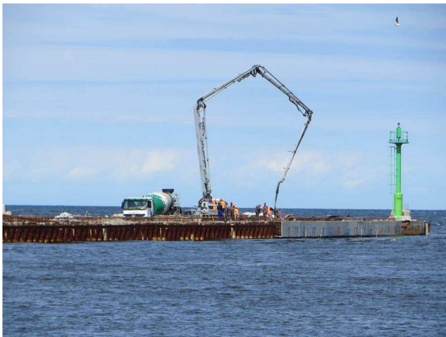
Zdjęcie 5 roboty żelbetowe na falochronie zachodnim
