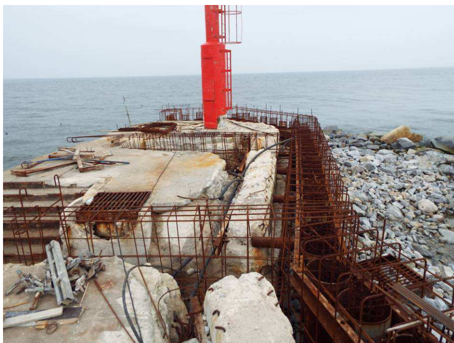
Zdjęcie 2 roboty żelbetowe na falochronie wschodni z Dziwnowie
