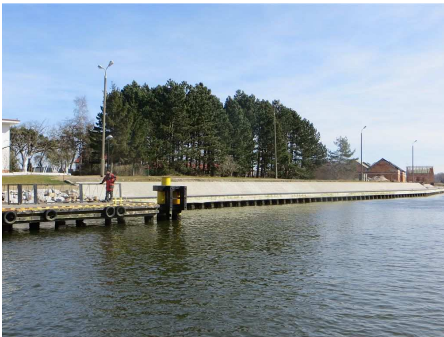
Zdjęcie 9 Umocnienie wschodniego brzegu Dziwny w Dziwnowie
