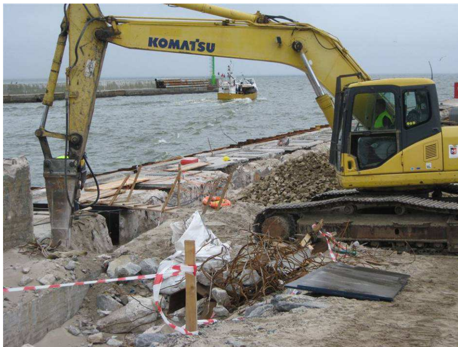
Zdjęcie 1 roboty rozbiórkowe na falochronie wschodnim
