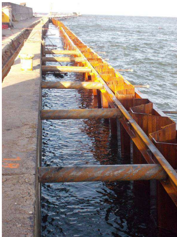
Zdjęcie 3 ścianka szczelna na falochronie zachodnim
