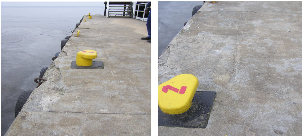
Fot 4 i 5 – betonowa nawierzchnia Pirsu Pasażerskiego.
