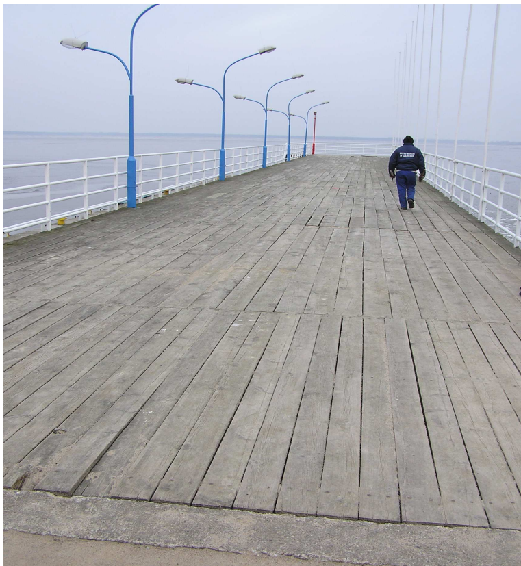
Fot. nr 2 – drewniana nawierzchnia Pomostu Spacerowego.
