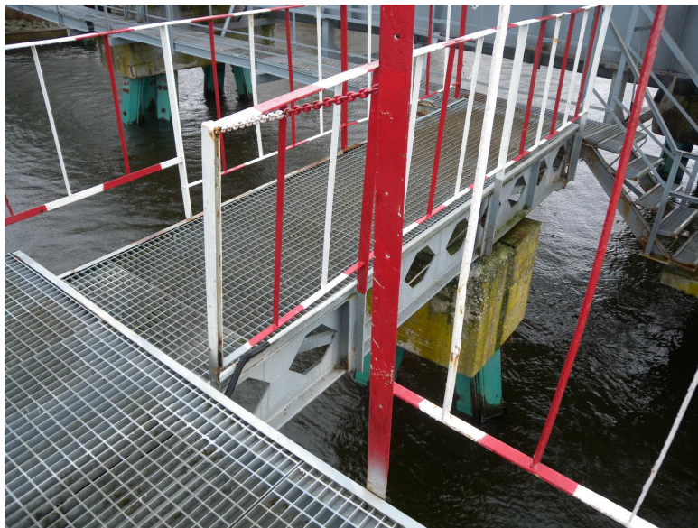
Rys. 3 Barierki pomostu komunikacyjnego
