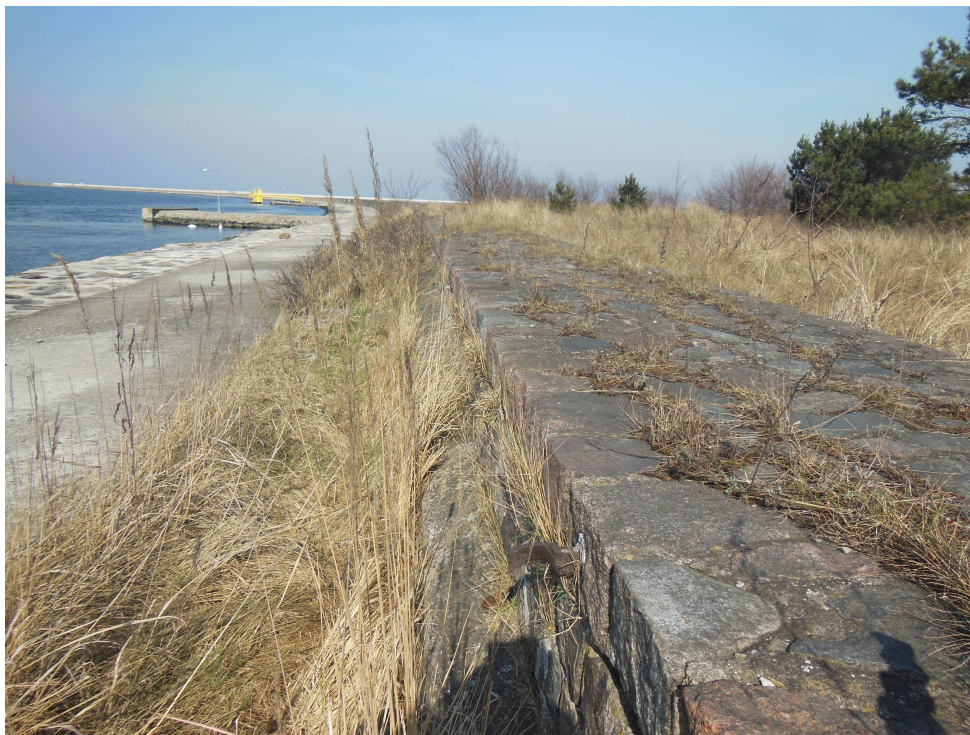
Mur (parapet) kamienny. Widok ogólny. foto 2
