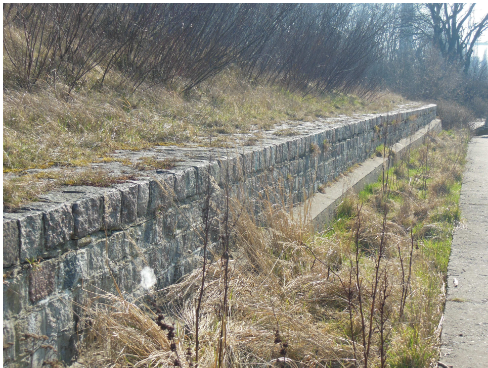
Mur (parapet) kamienny. Widok ogólny foto 1
