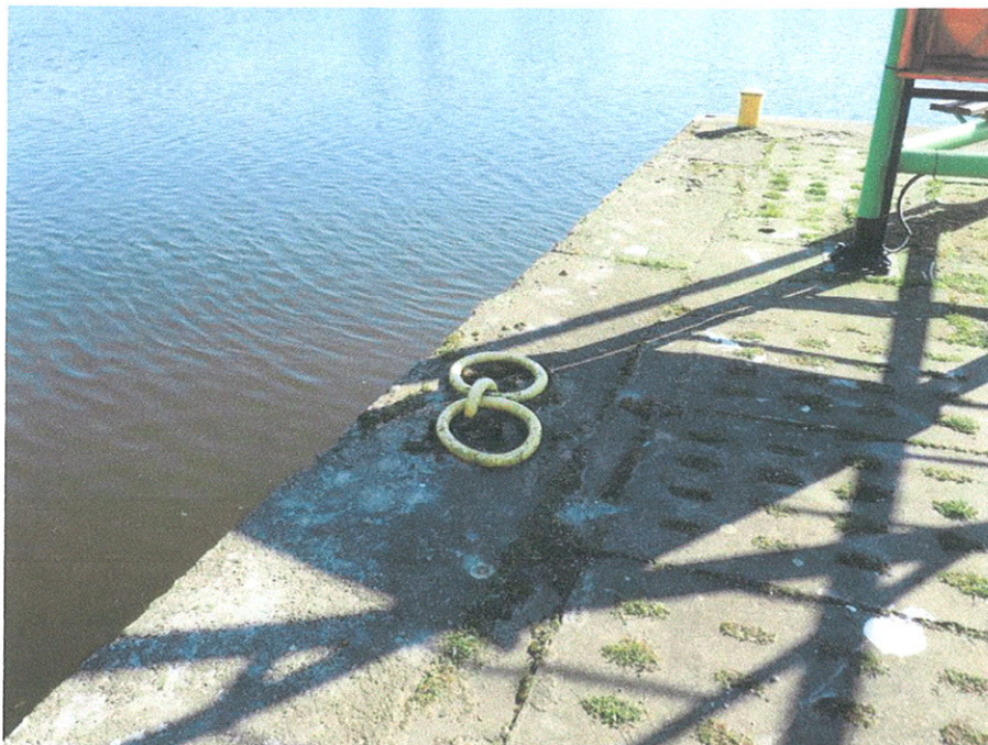
Fot 5. Odcinek O-P- oczep nabrzeża
