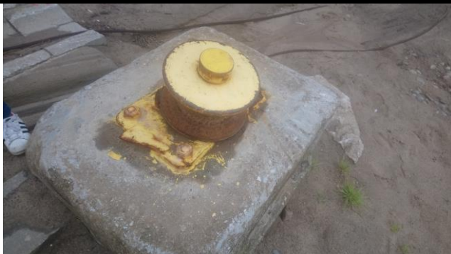
Fot. 1. Rolka kabestanu na bloku oczepowym
